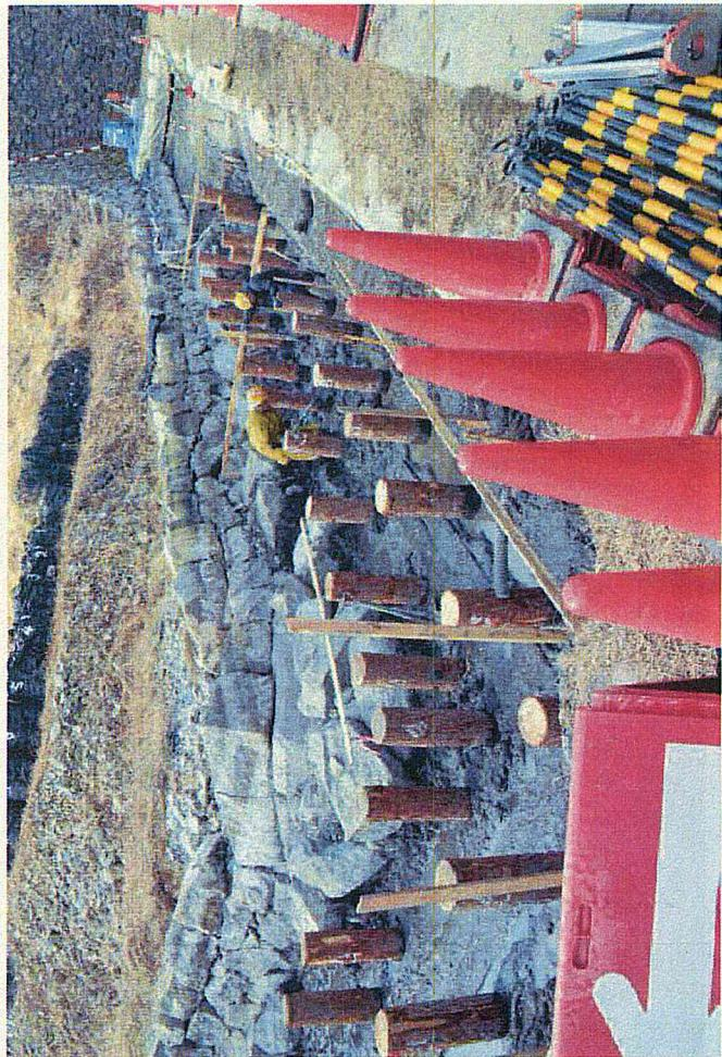
写真1 桁打設状況 東面 北東から
