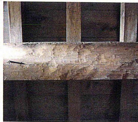
東南隅櫓一階の梁下端
