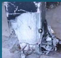
IS値0.37でも最上階の柱は修理限界を超えたので壊して作り直す。
