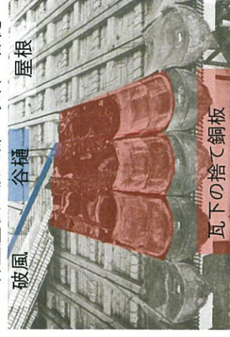
各重屋根と破風部の取合い谷樋
