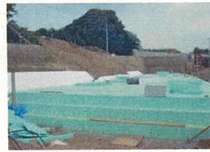
図2-3-3 EPS工法の工事状況の例
