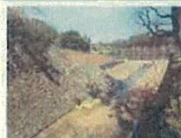
崩壊・はらみ出し部分の修復を昭和45年度から継続的に行っており、現在は本丸堀手馬出の修復を行っています。文化財調査も並行して行い、石垣を積み上げる伝統技術や石垣のはらみ出しの原因解明も目的としています。
