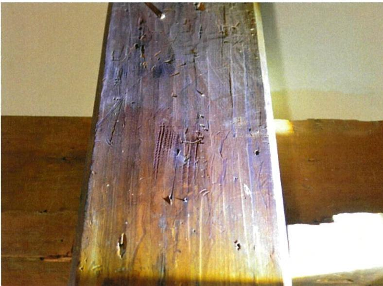
細幅の台鉋で仕上げられた柱(部分的に鋸の加工痕跡有り)
