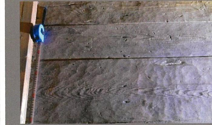
槍鉋による仕上げ(一部、細幅の台鉋仕上げ)
