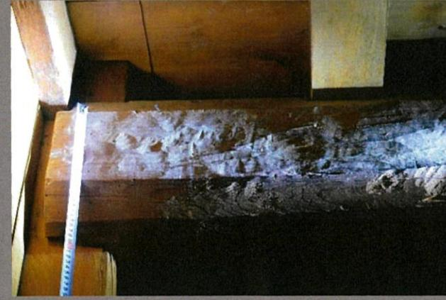
鋸による仕上げ(上記撮影部材の柱際)
