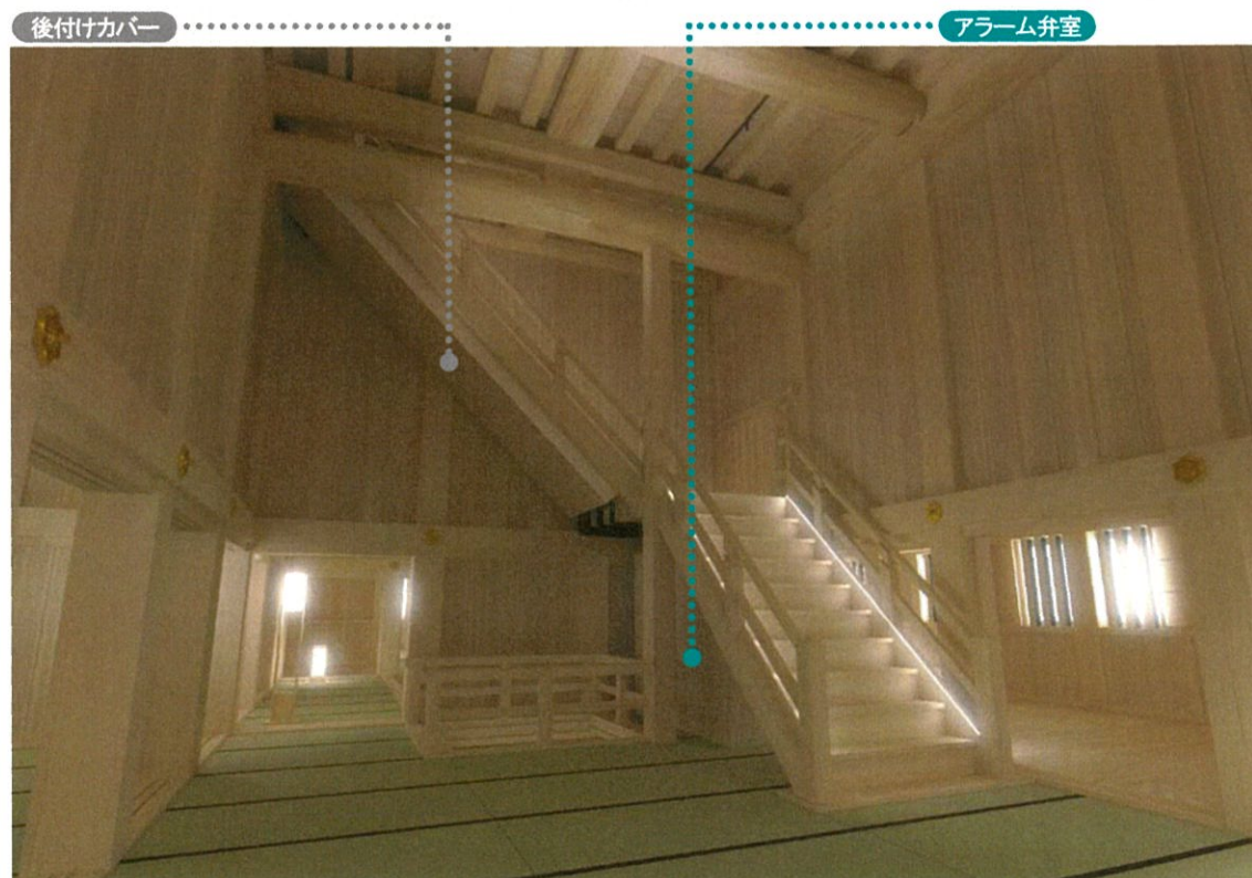
Ⅲ 表階段(カバー有り) ※配管が多数並ぶ場合は、後付けカバーの設置も検討しています
