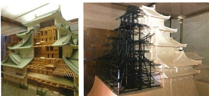
木造天守構造模型 SRC天守構造模型
