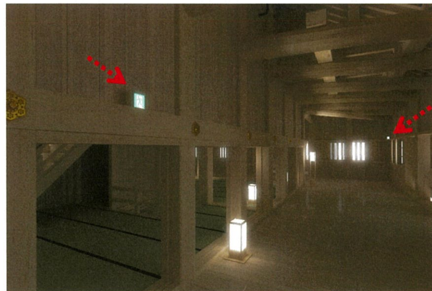
II 西入側(誘導灯)
