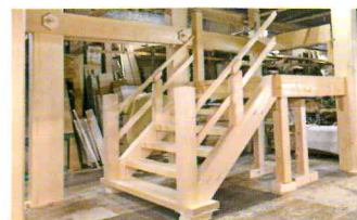
仮組みをし、部材の納まりを確認しながら調整しました。
