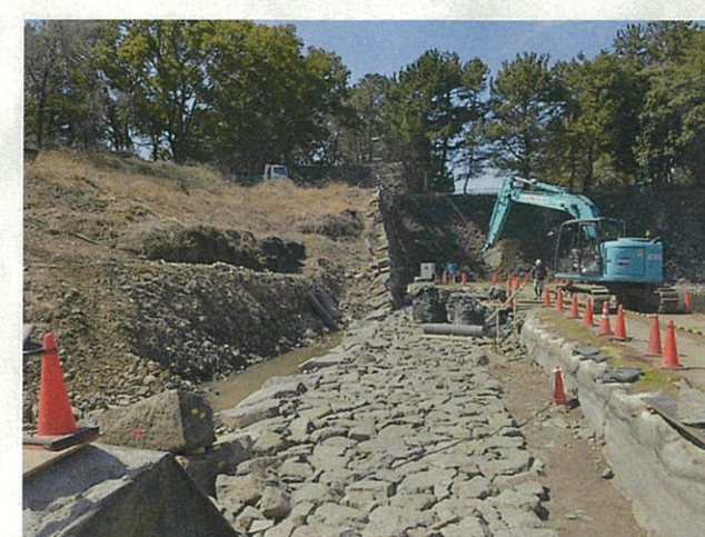
写真10 H30年度完了（北面）（東から）
