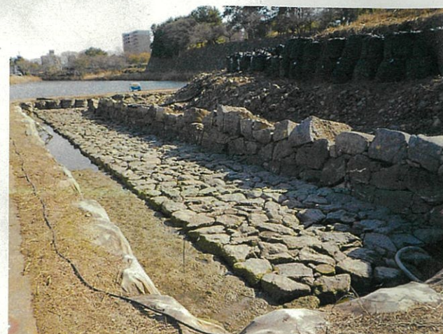
写真4 H30年度着工前（北面）（北西から）
