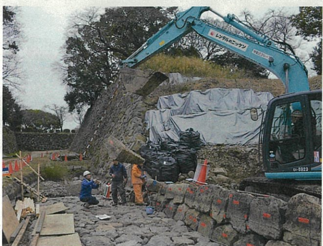
写真7 H30年度石材取り外し作業（東面）（北東から）
