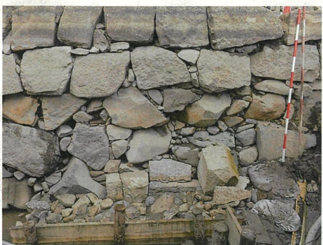
写真11 H26年度石垣前面の石材（北トレンチ）（東から）
