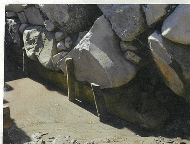
写真12 H26年度石垣基礎の土台木（北トレンチ）（北東から）
