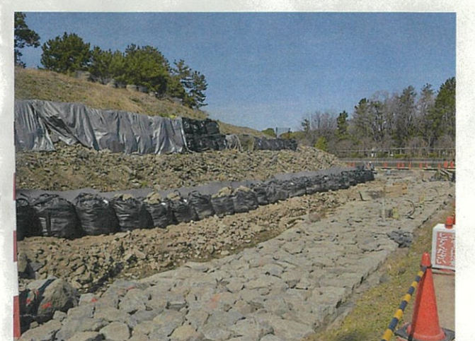
写真9 H30年度完了（東面）（南東から）
