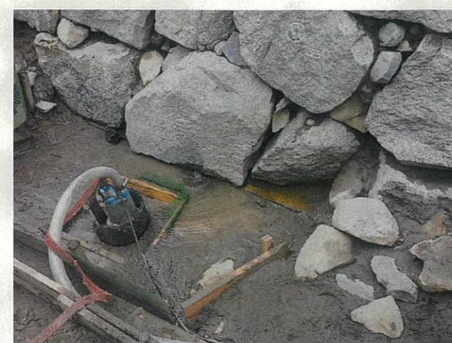
写真14 H26年度石垣基礎（南トレンチ）（東から）
