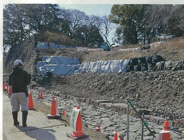
写真8 H30年度写真測量作業（東面）（北東から）
