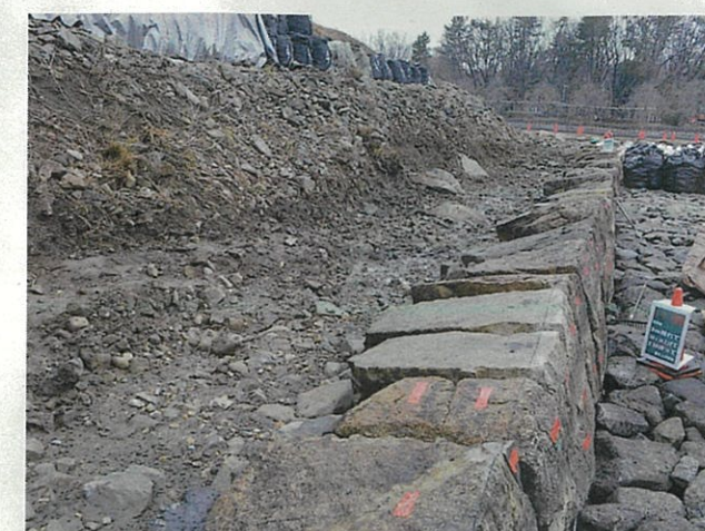
写真6 H30年度石垣背面状況（東面）（南から）
