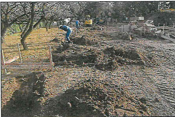
写真2 現場状況／北から
