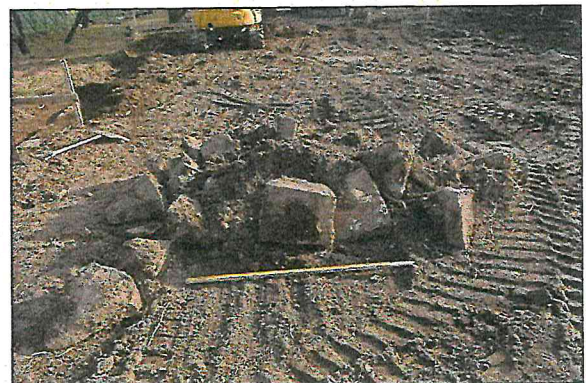
写真3 き損した石材状況／北から
