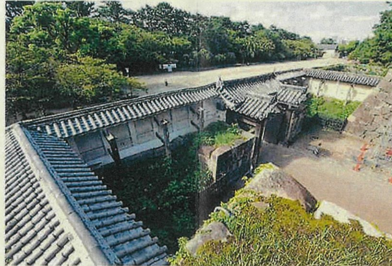
①名古屋城表二の門・土塀 前景(北東より見る)
