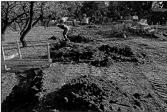
写真2 現場状況／北から
