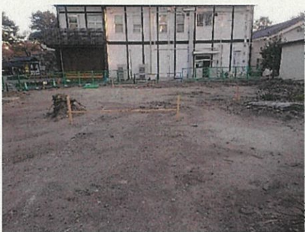
④学芸員の立会いなく、掘削が行われていたもの
