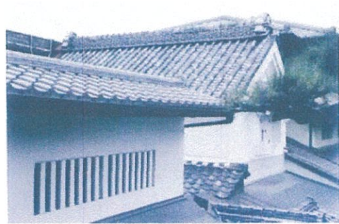
写真1 土蔵西側外観(本館2階より)
