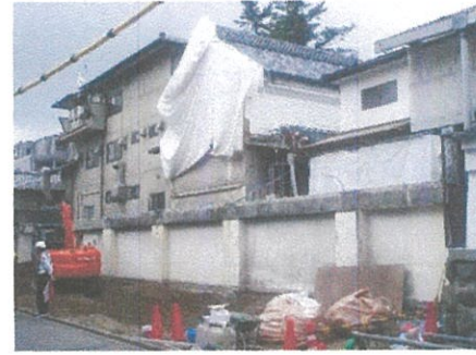
写真2 土蔵東側外観(鳥屋筋より)
