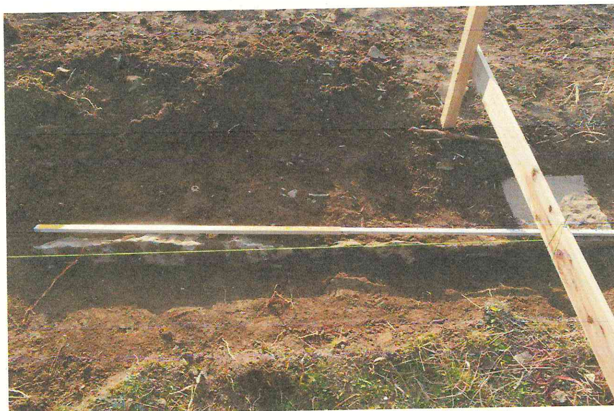
写真4 き損直後の石列残存状況現場状況／東から
