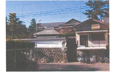
旧館 (視点②より)
