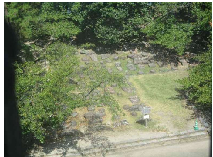
現天守閣 1 階北側窓からの俯瞰 ※樹木の陰になり、全体像の眺望を阻害するとともに、日陰となることで湿潤状態が長く続く
