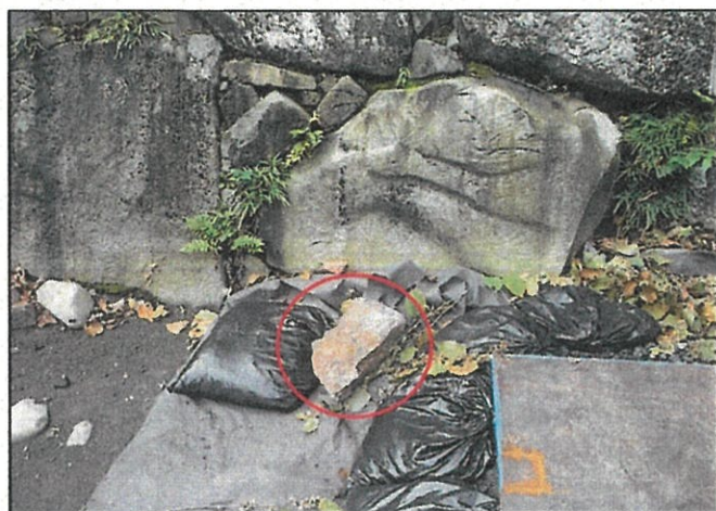
写真3 落下した石材片
