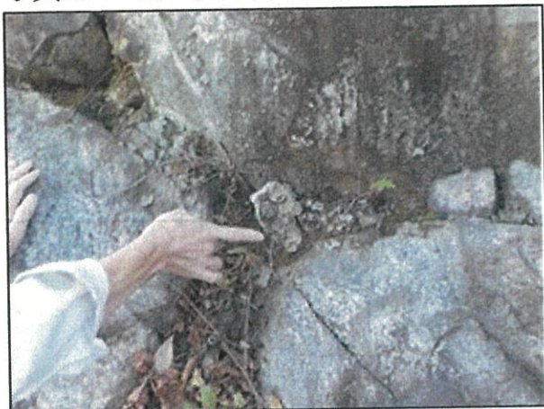
写真3 落下したモルタル片
