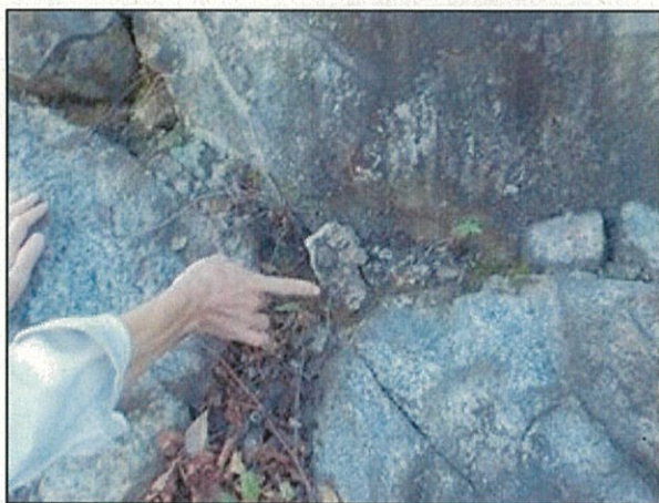
写真 3 落下したモルタル片
