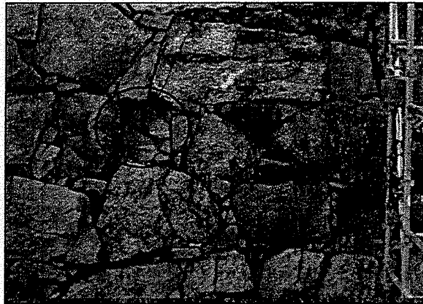
写真2 石材片落下後の状況
