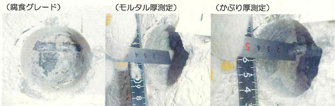
写真 3.2 鉄筋かぶり厚さ・腐食腐食の調査
