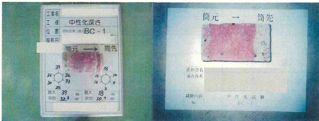
写真 3.3 コンクリート中性化深さの調査
