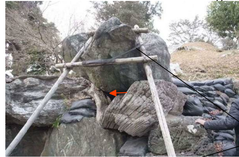
南面の樹木根の状況
