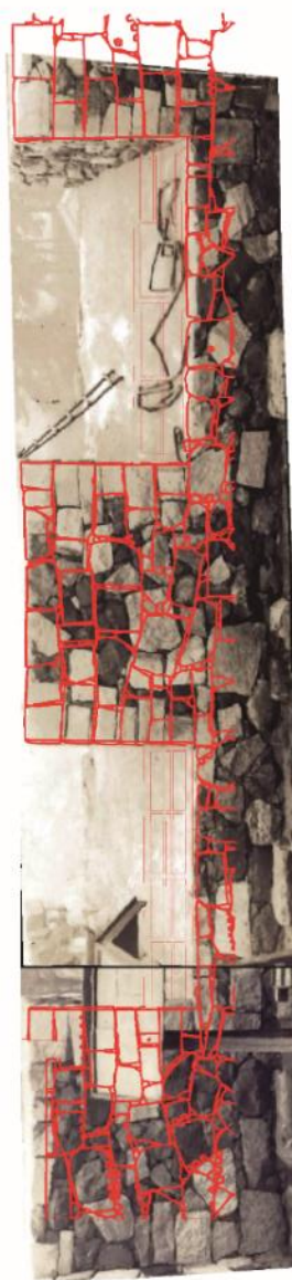
④積替工事後_名古屋城天守閣跡石垣積替工事写真帳_027,28 (1956 年)
