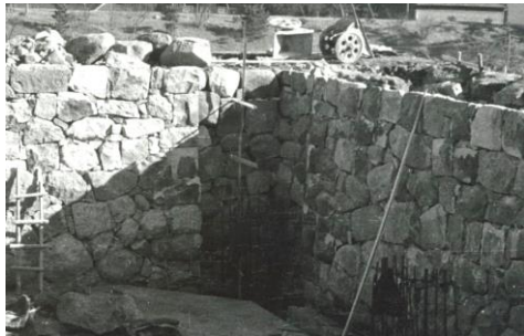
図17 穴蔵石垣の積み直し状況
