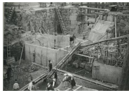
大天守の枡形の石垣をはずしケー ソンを施工している
