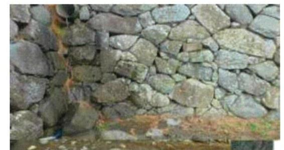
図04 U065\_間詰め石の抜け落ちと築石の割れ1.jpg
