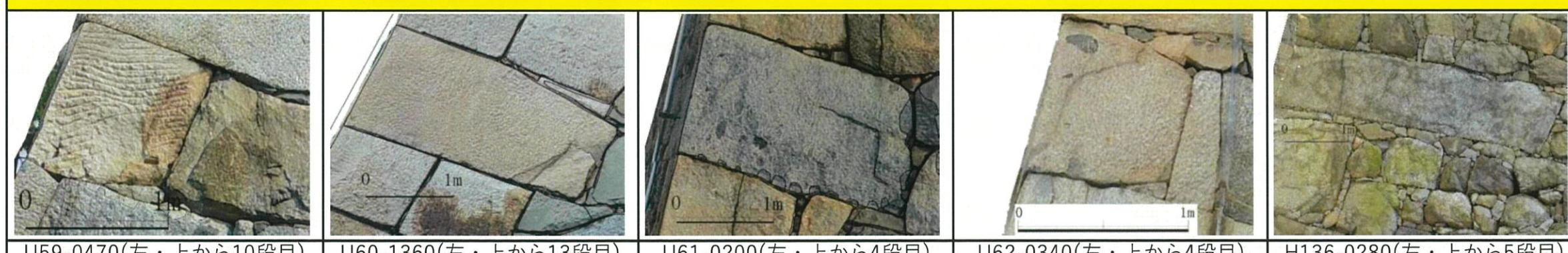
D : 亀裂が貫通し、分離した石片が剥落する可能性がある状態
