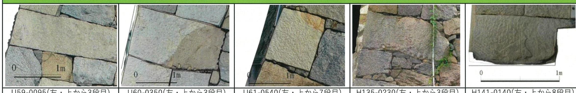
C : 損傷が見られる(開口亀裂)が、剥落の可能性は低いと判断される状態
