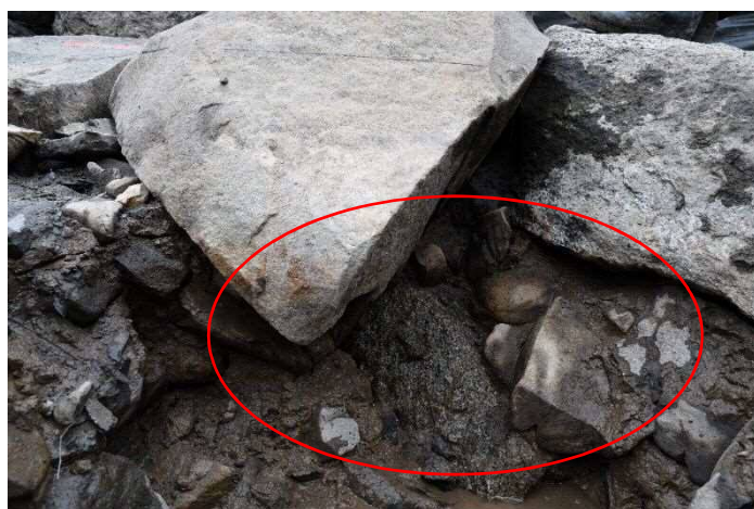
図9 001-5054 下の築石及び介石状況（西から）
