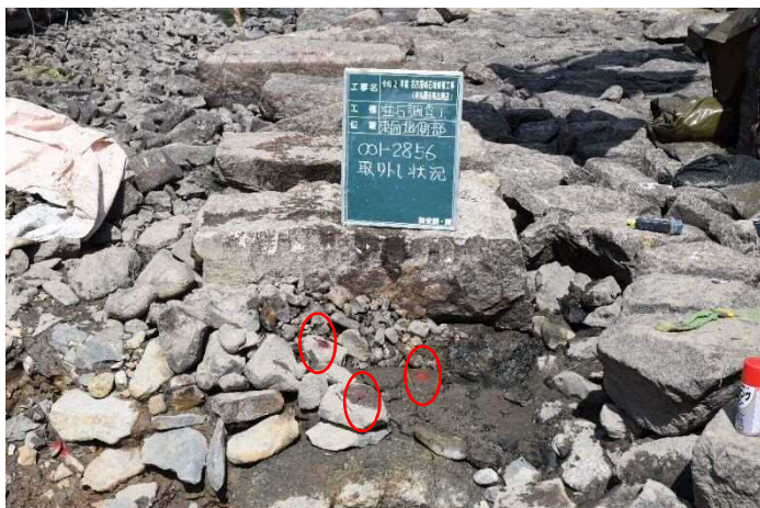
図4 取り外し状況（南から）赤丸内が接点
