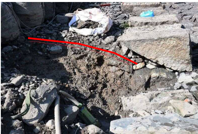
図3 001-2856 背面堆積状況（赤い線より上がヘドロ状堆積、下が黄褐色粘質土）（南から）
