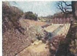
崩壊・はらみ出し部分の修復を昭和45年度から継続的に行っており、現在は本丸堀手馬出の修復を行っています。文化財調査も並行して行い、石垣を積み上げる伝統技術や石垣のはらみ出しの原因解明も目的としています。
