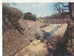
崩壊・はらみ出し部分の修復を昭和45年度から継続的に行っており、現在は本丸搦手馬出の修復を行っています。文化財調査も並行して行い、石垣を積み上げる伝統技術や石垣のはらみ出しの原因解明も目的としています。
