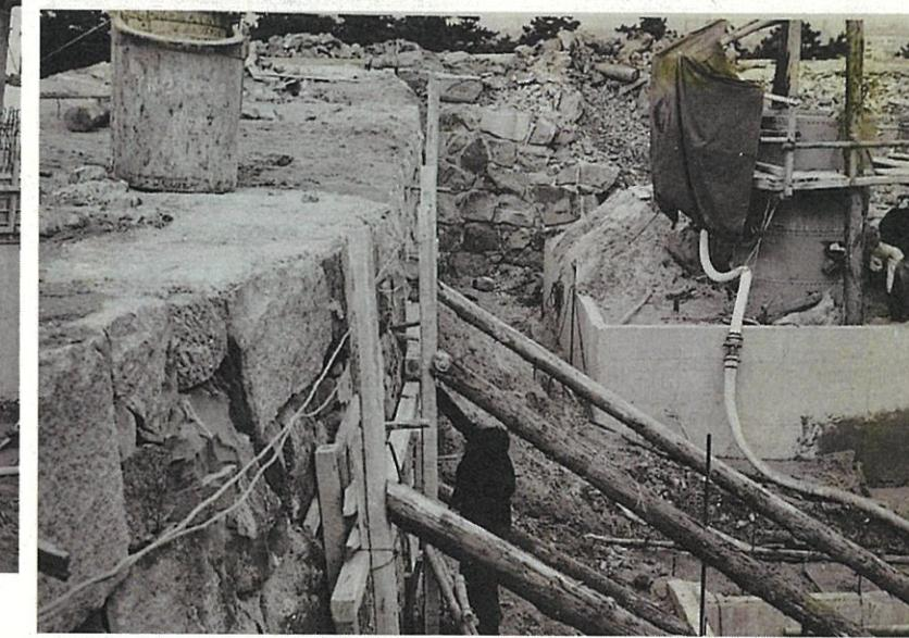
1号ケーソン(西北)沈下の際、ウォータージェットによって東南角に陥没を生じる。
