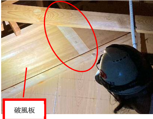
写真4（落下した吸付棧の元位置）
