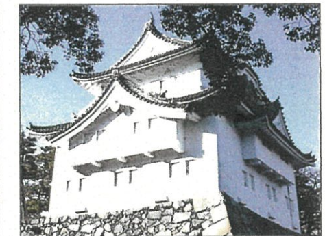
東南隅櫓（重要文化財）
