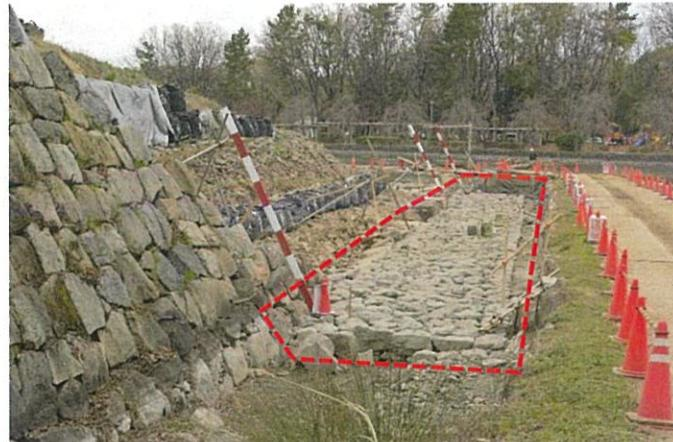
写真2 根石部の安定化（柱工）
