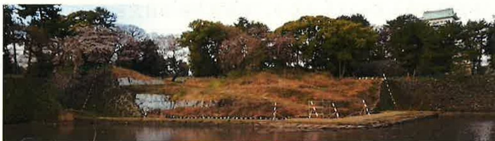
写真 1 解体完了写真
