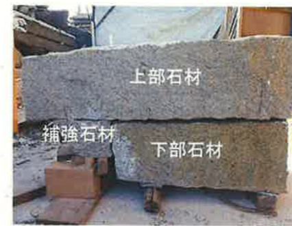
写真2 逆石補強方法
