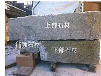
写真 2 逆石補強方法
