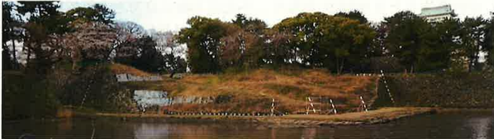
写真 1 解体完了写真
