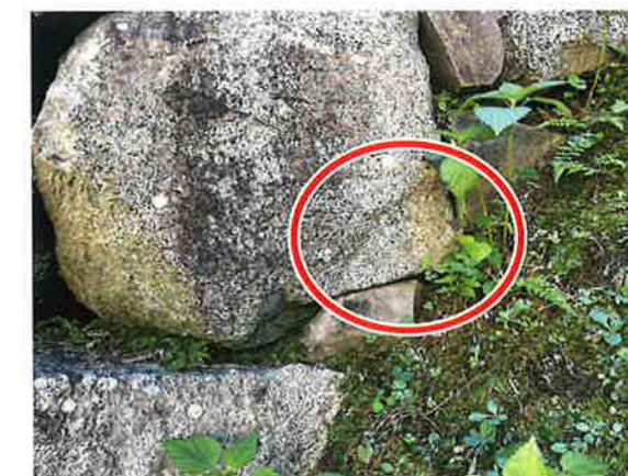
図8 西側旗台石垣(108H) GL+2.0m 付近 雁木痕跡の可能性がある加工痕
