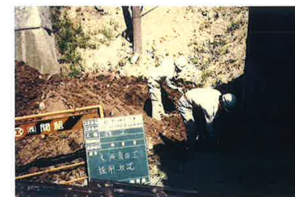
図10 昭和60(1985)年度表二の門木柵復旧工事
