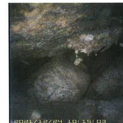
図6 東北隅櫓石段 P7 撮影画像 (深さ0.1m・正面、明るさ補正処理)
