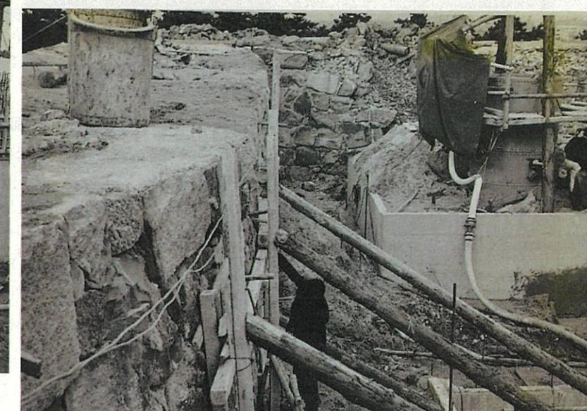
ケーソンの沈下に伴い石垣上部に変形を生じた。
