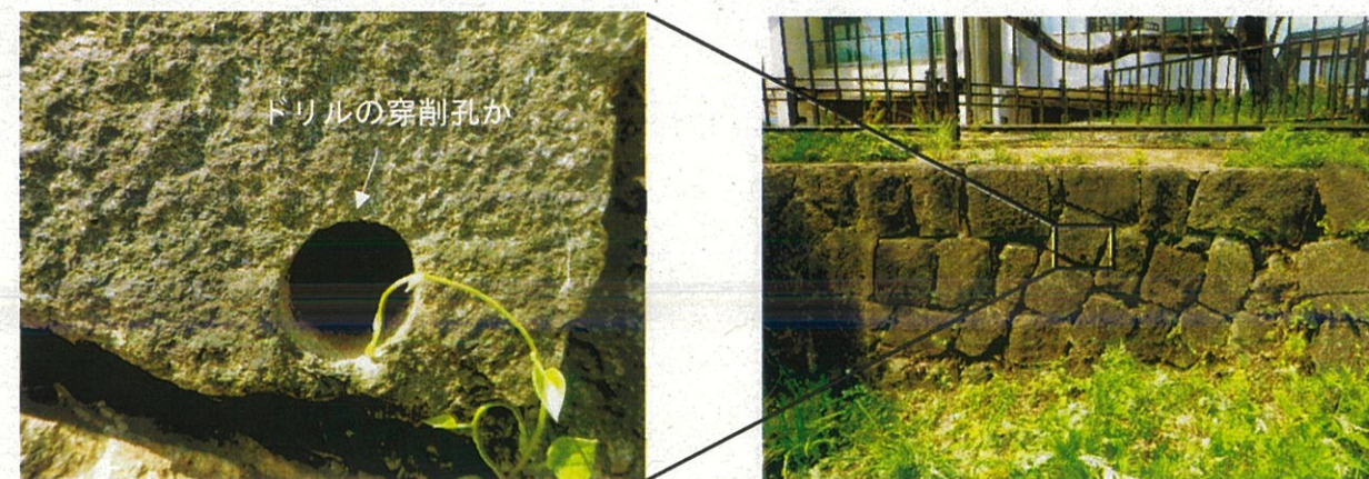
図9 現存する辰之口南側の石垣
