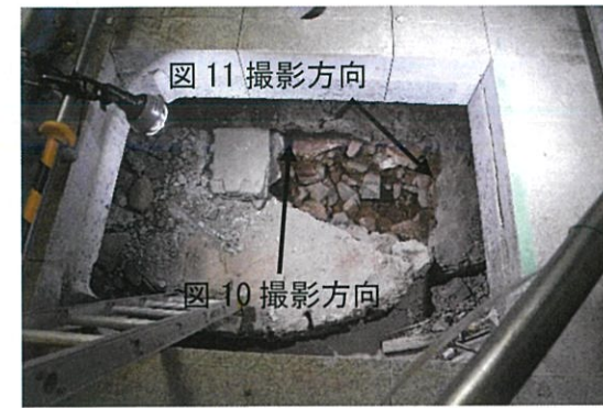
図 9 ③調査区全景(西から)
