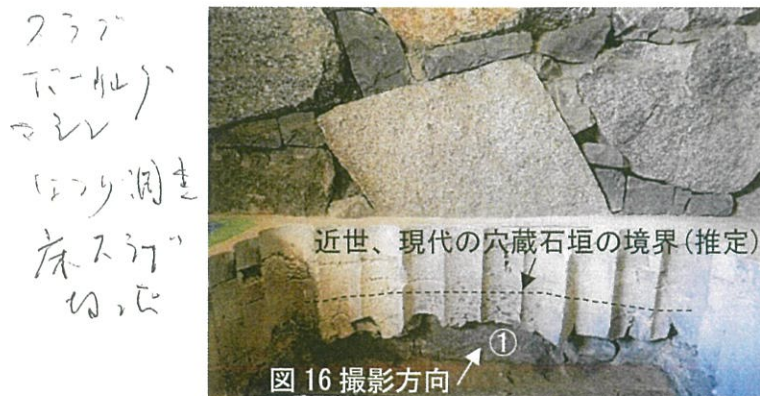
図 15 コンクリート床下の石垣 (東から)
