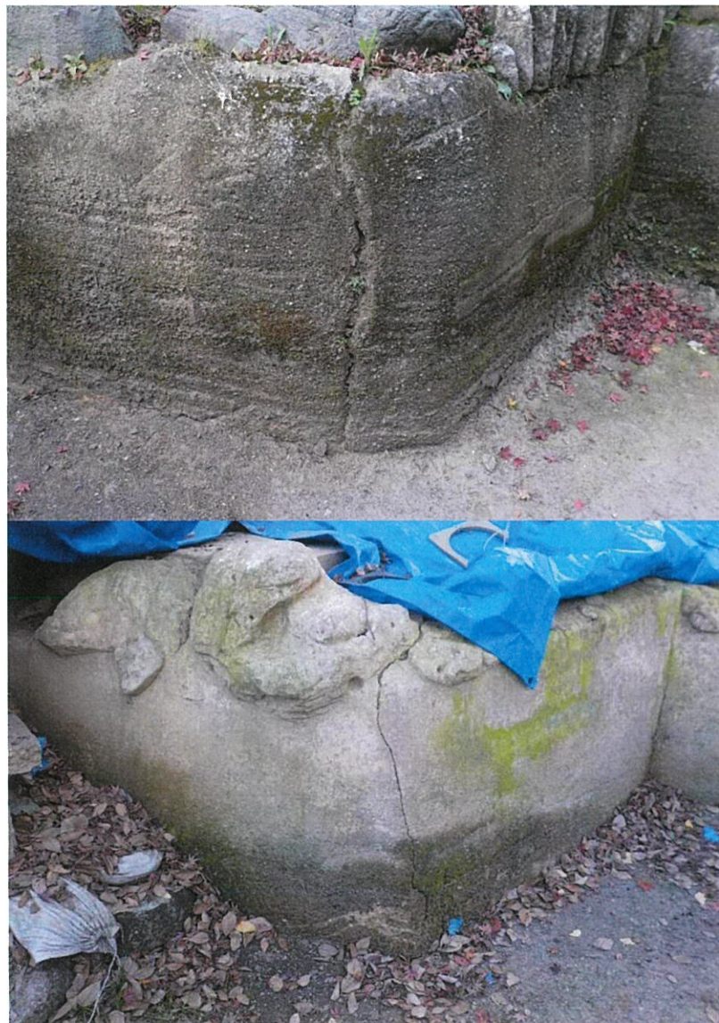
修理箇所の例（写真）
