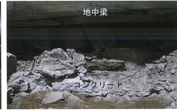
図 10 石垣前面の障害物(西から)
