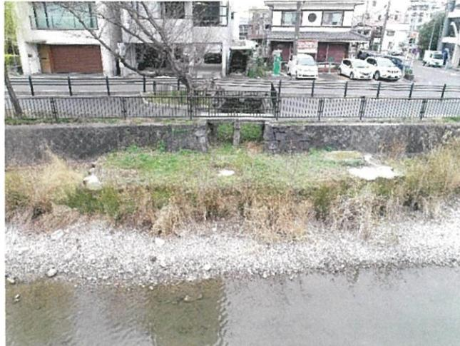
平成 10（1998）年度に実施された外堀護岸改修工事の際に設置された（幅 12.5m × 奥行き 2.5m）。鋼矢板（長さ : 4 m）で囲い、土を埋め戻し、上部にコンクリート（厚さ : 10 cm）を打設したもの
