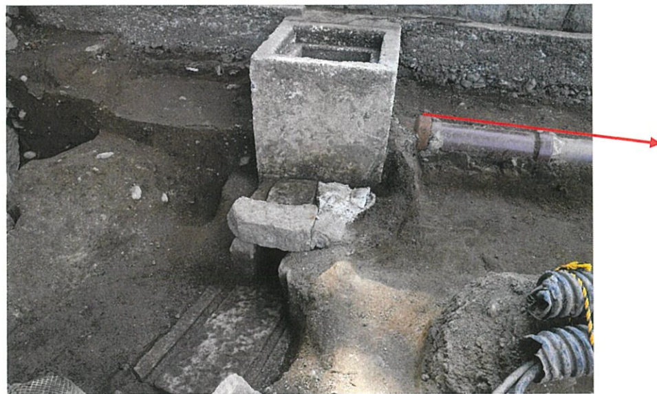
写真8 雨水枿との接続部（東から）
