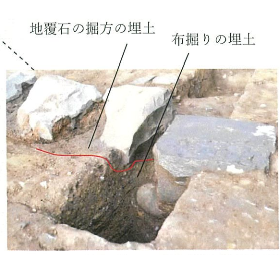
写真2-5 礎石・地覆石の設置状況 (南西から)
