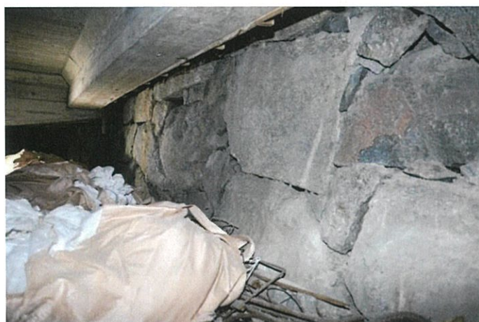
図 16 調査区東側の石垣(東から)
