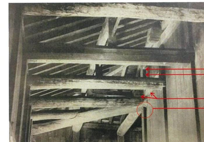
2階の側隅柱の側面で2階床梁が取合うことがわかる
