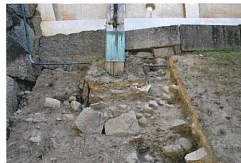
図7 調査区4 土堀控柱の根固めか
