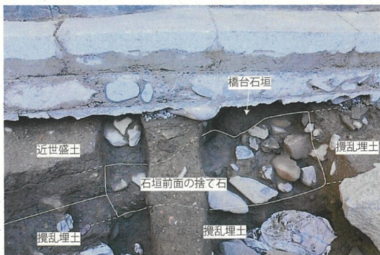
図 6 ⑨調査区東側の石垣前面捨て石(西から)
