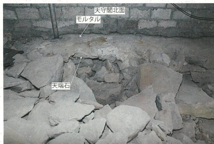
図12 背面②調査区土築石(南から)
