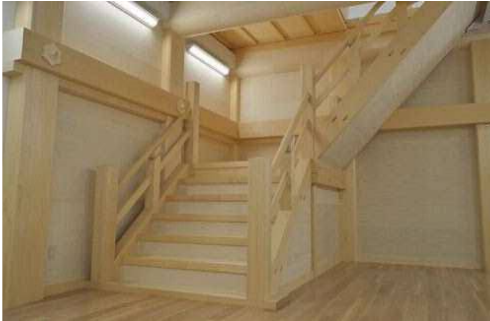
「名古屋城木造天守閣階段体験館」 に設置されている実物大模型の階段 （木造天守の1階から2階の階段）
