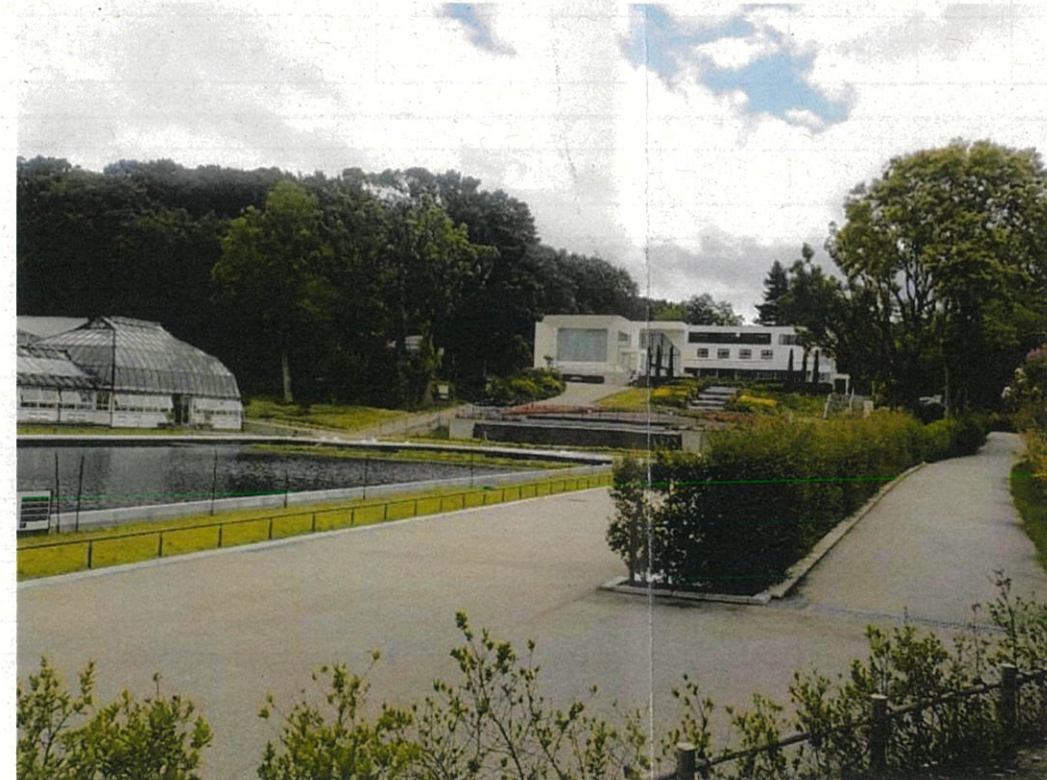
緩やかな勾配の園路を新たに設け、バリアフリーに配慮した移動経路を確保した
