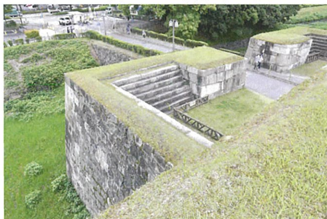
図 17 二之丸東二之門の土塀天端
