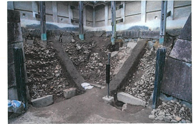
図3 西側土塁 完掘状況 (北東から)
