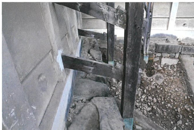
図 15 西側土塀 土塀背面検出状況
