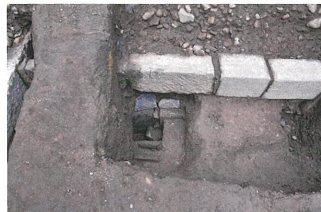
図 10 東側土塁 切石直下サブトレ検出状況
