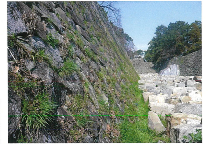
石垣裾部の状況
