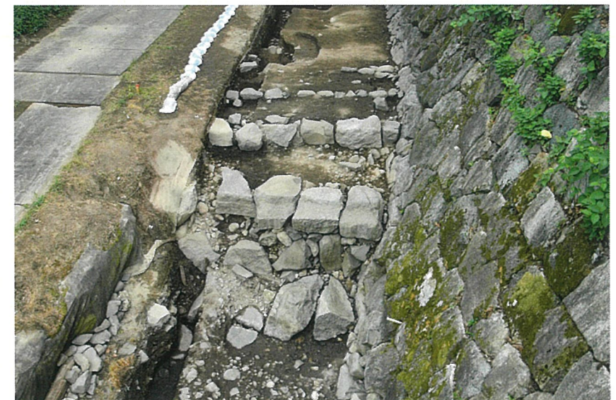
SS1 ～ SS4(北から)
