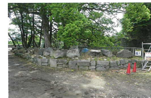
写真① 北側低石垣 (北東から)
