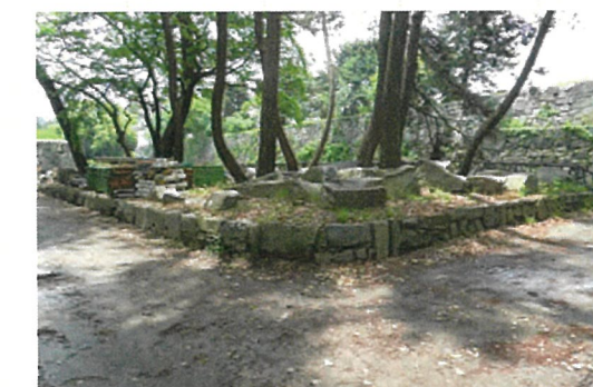
写真③ 南側低石垣 (北東から)
