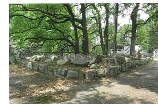
写真② 北側低石垣 (南東から)
