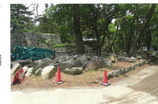
写真④ 南側低石垣 (南東から)
