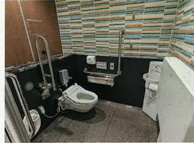
【一般トイレ 広めの個室ブース】
