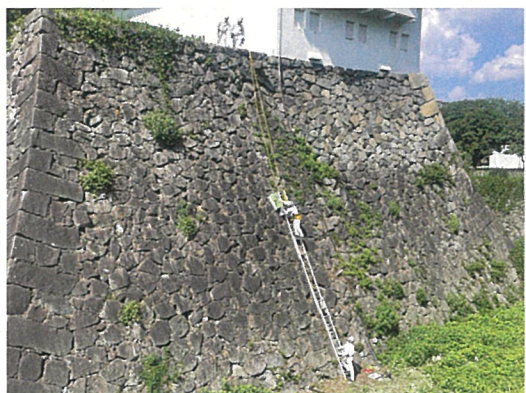
図3 レーダー探査実施状況 (021H)
