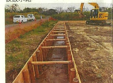
仮設沈砂池 たまご水が浸透している。
