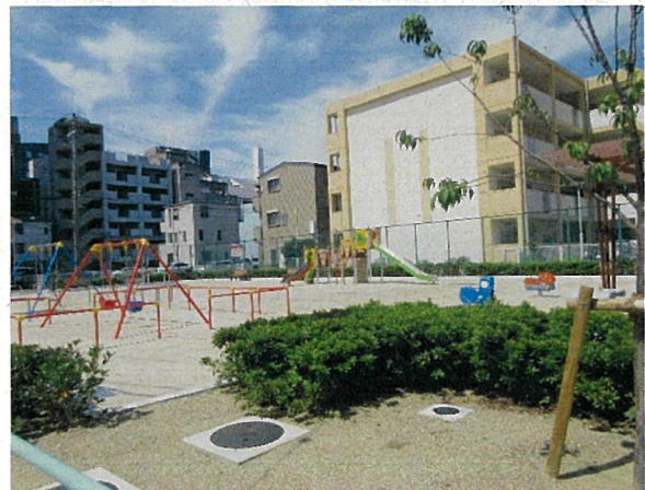
①街区公園 整備後 (令和5年)
