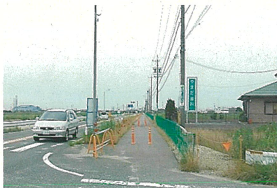
②都市計画道路万場藤前線 整備前（平成24年）
