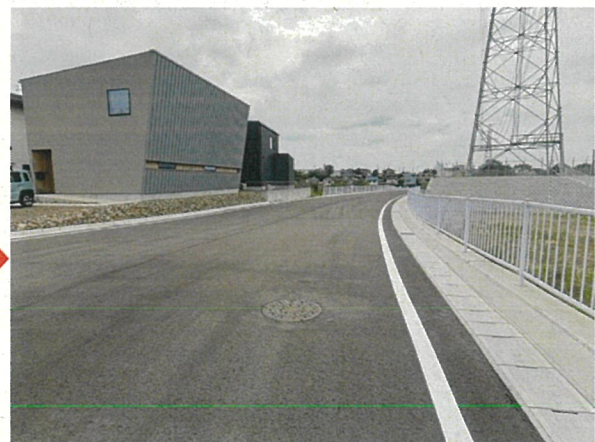
整備後 (令和7年)
