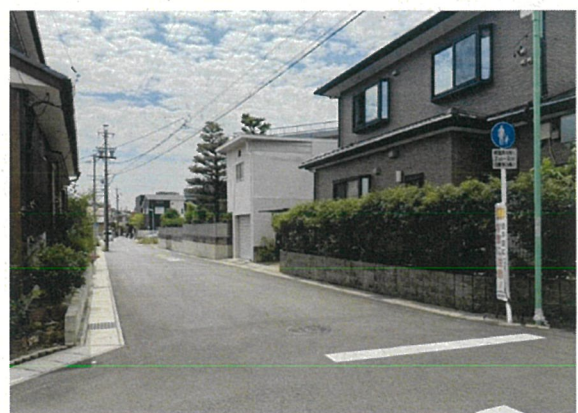
②区画道路 整備後 (令和7年)
