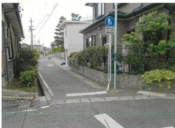
②区画道路 整備前 (令和3年)
