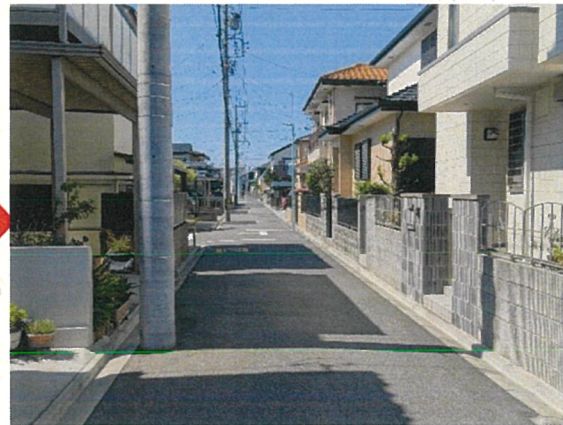
整備後（令和6年度）
