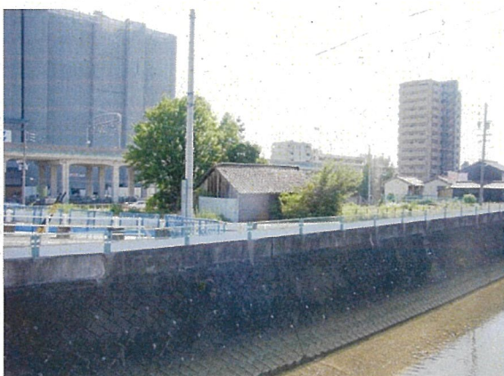
②A工区 移転補償前（平成26年度）
