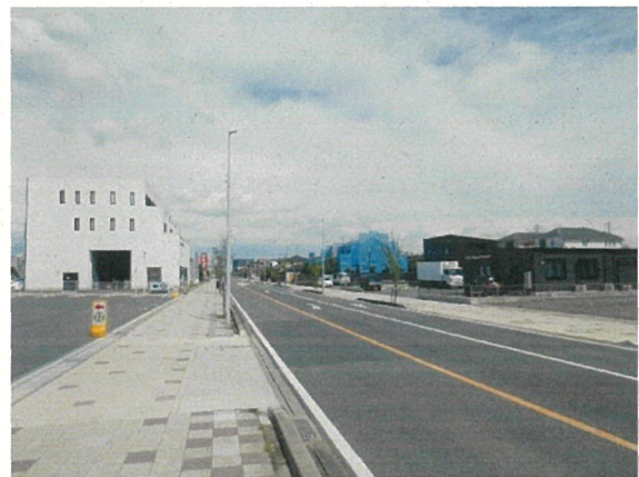
①都市計画道路南秋葉線 無電柱化整備後（令和7年）
