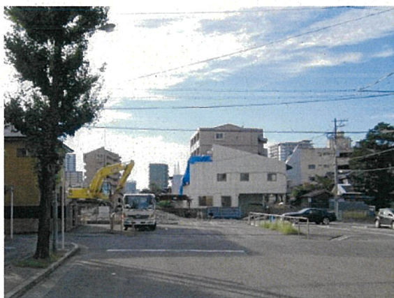
②都市計画道路 整備前 (平成25年)
