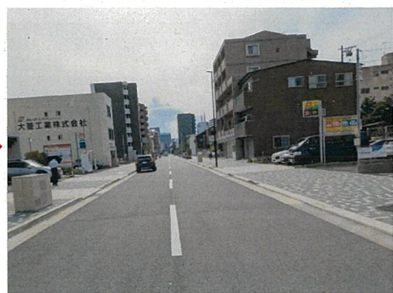
整備後 (令和7年)
