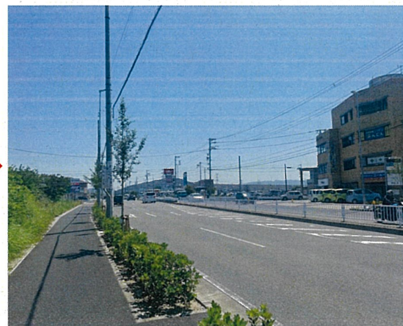
整備後 (令和7年)
